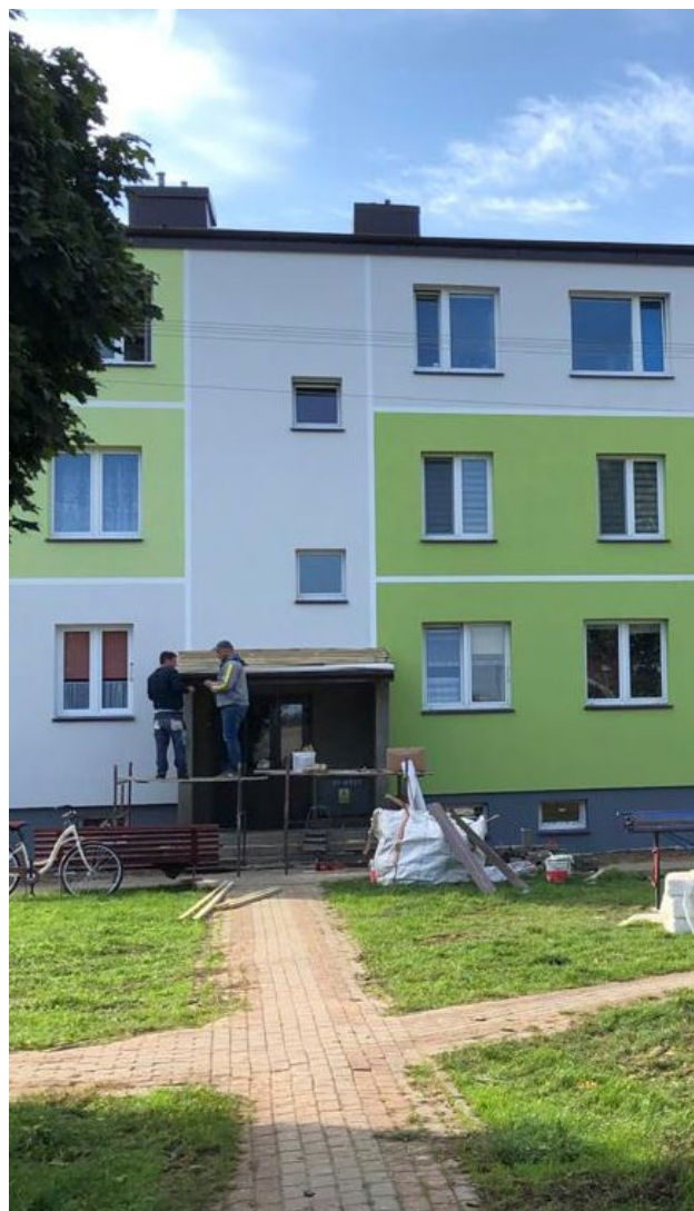
Trwa ocieplanie bloków przy ul. Świętojańskiej
